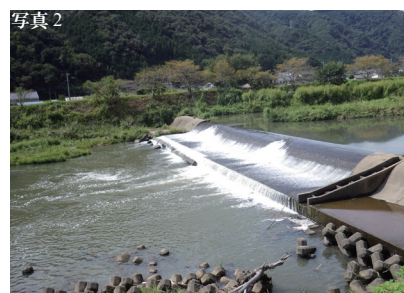
堰から越流しているのに魚の通り道には水はない状態
