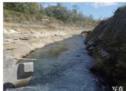
大規模な河床低下が生じた河川の状態
