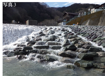
砂防施設に設置された石組み魚道
