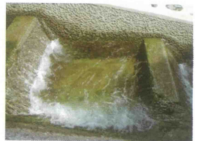
魚・えび・かにの道のための水流制御の一例
