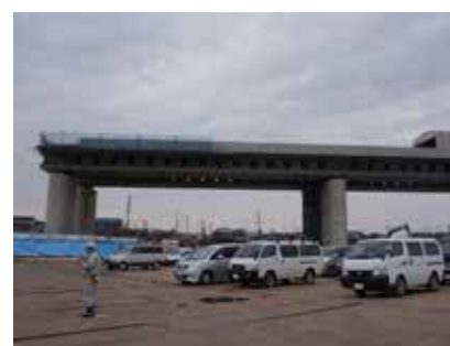
橋梁：プレキャストコンクリート橋梁建設現場
