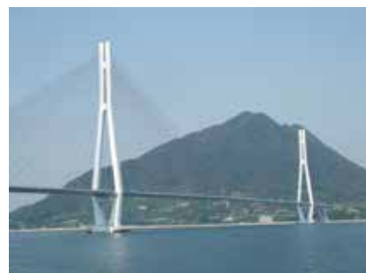
日本の長大橋の一つ「多々羅大橋」
