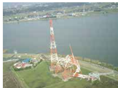
台風による強風で倒壊した送電線鉄塔
