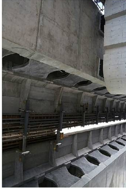
バタフライウエブ構造の桶川第二橋梁
