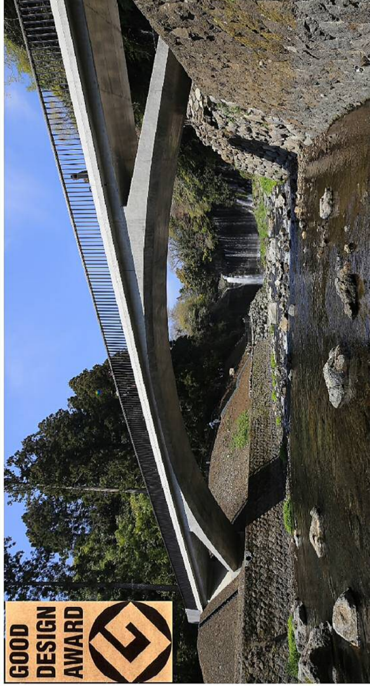
プレストレストバラスト扁平アーチ構造というコンパクトな構造で地形改変を抑えた滝見橋
