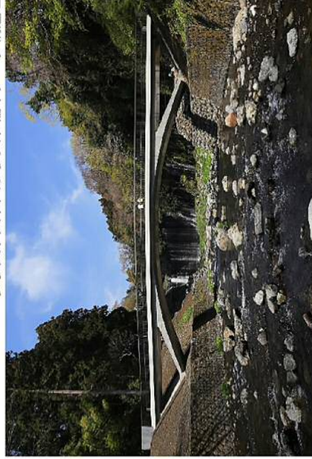
プレストレストバラスト扁平アーチ構造というコンパクトな構造で地形改変を抑えた滝見橋
