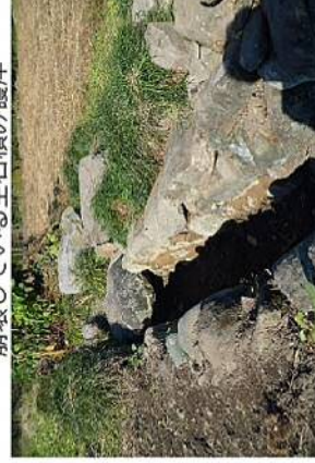
崩壊している空石積み護岸
