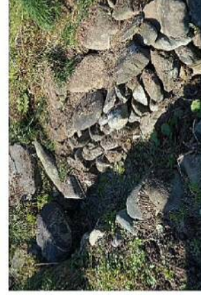
崩壊している空石積み護岸
