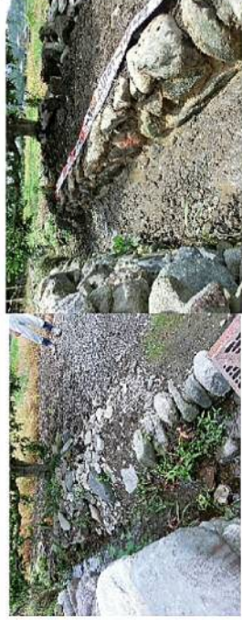
崩壊している空石積み護岸
