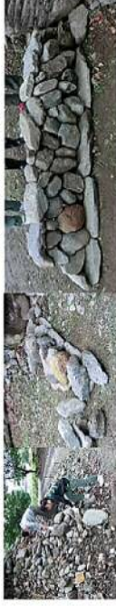
崩壊している空石積み護岸
